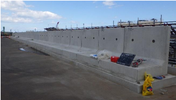
（写真2） L型擁壁据え付けの状況 （3号機タービン建屋東側において 南側から撮影）
