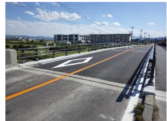
③補修施工を行い完了
