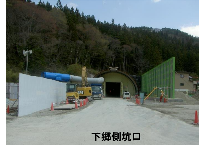
(仮称)田代トンネル
