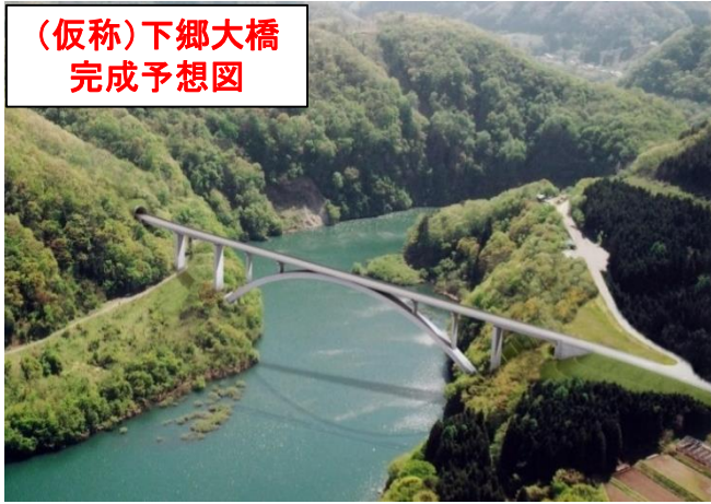
(仮称)下郷大橋 令和元年12月
