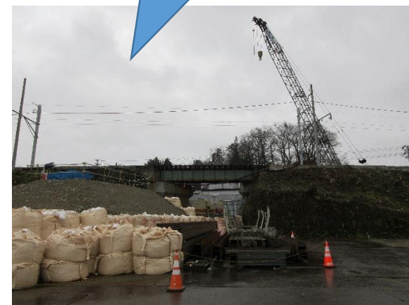
南会津町田島地内
