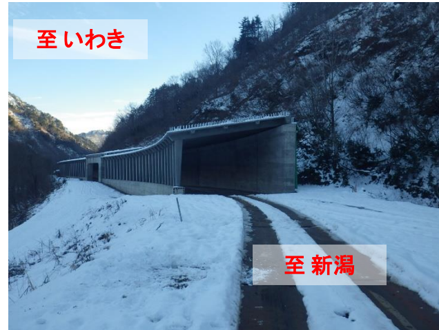
スノーシート工事状況
