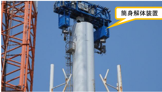
(写真2) 排気筒頂部の状況 12時頃撮影
