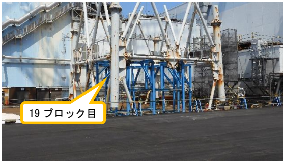
(写真3) 19ブロック目仮置き状況
