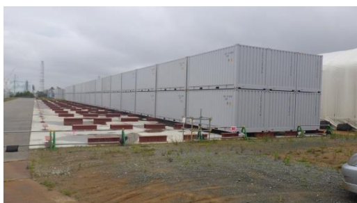
(写真1-1) エリア北側のコンテナの保管状況
