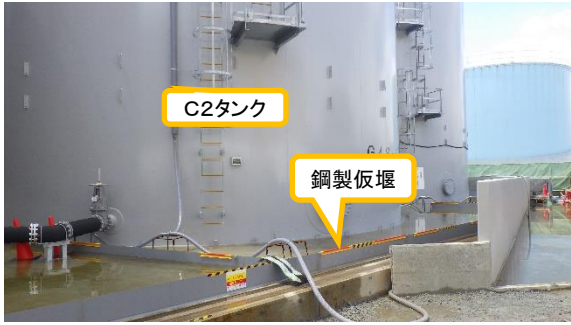
(写真 2) 使用開始されているタンクの例 (北東側から撮影)
