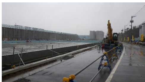
(写真1-1) 前回撮影。北側から撮影。 写真中央奥がG7タンクエリア。
