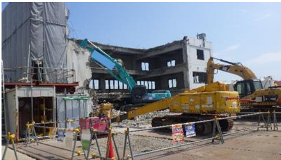
(写真4-2) 7月25日撮影 (南西側から撮影)
