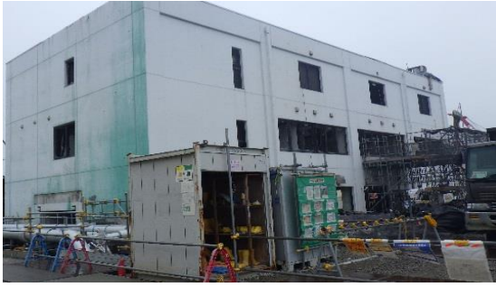
(写真4-1) 6月24日撮影 (南西側から撮影)
