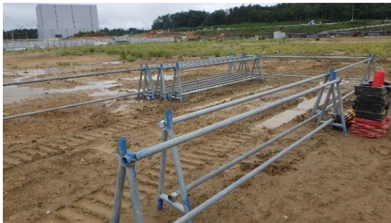
(写真1-2) 設置されていた単管パイプの バリケード
