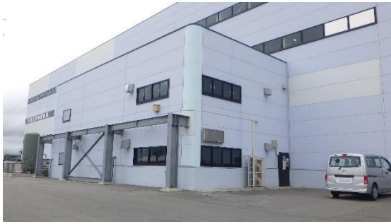
(写真2) 大型機器メンテナンス建屋概観
