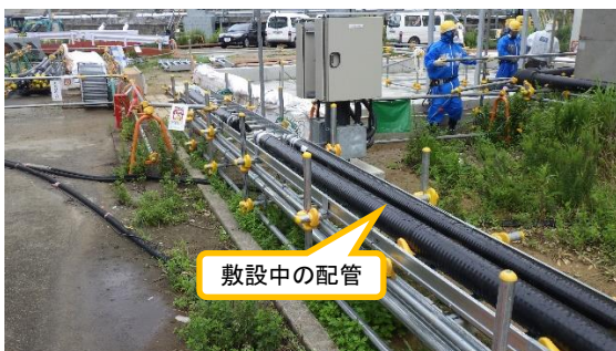
(写真3) 敷設中の移送配管
