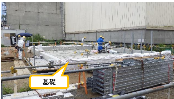
(写真2) サブドレン除鉄装置設置予定箇所
