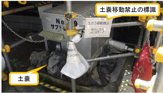
(写真1) サブドレンピットNo. 19周囲の状況
