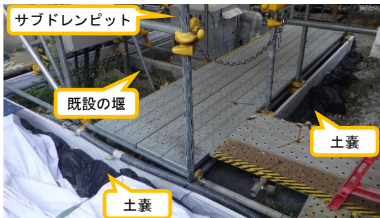
(写真2) サブドレンピットNo. 18周囲の状況
