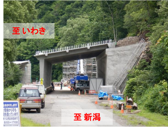
スノーシエツト工事状況
