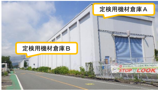
(写真1) 定検用機材倉庫外観 (南東側から撮影)
