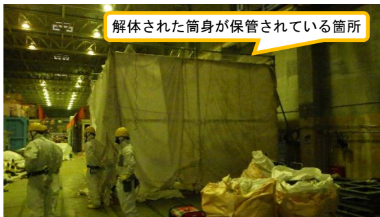
(写真2-1) 定検用機材倉庫B内部の状況 (東側から撮影)
