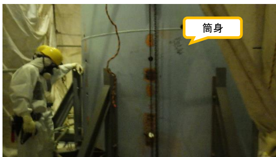
(写真2-2) 解体された筒身の保管状況
