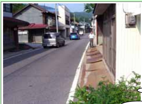
県道小野郡山線の状況
