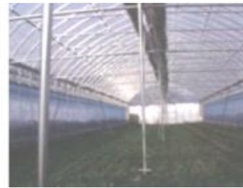
中柱（仮支柱）設置の写真
