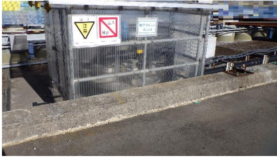
(写真4-1) 地下水ドレンpond Aの状況① (南側から撮影)
