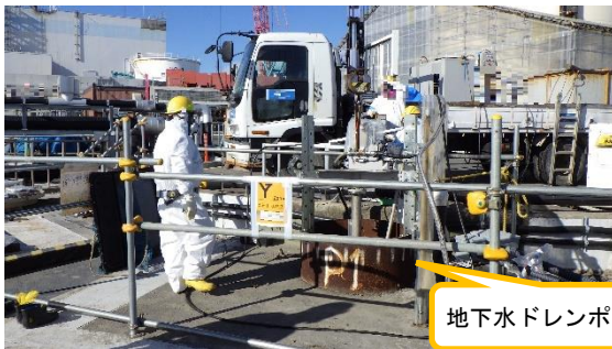
(写真5) 地下水ドレンpond Bの状況 (南東側から撮影)
