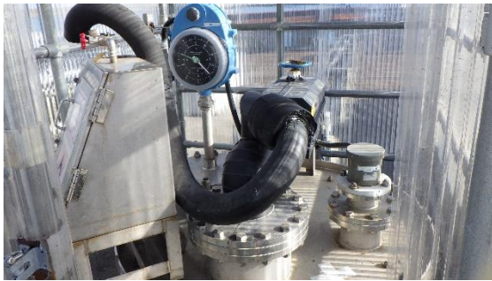
(写真4-2) 地下水ドレンpond Aの状況② (カバー内を西側から撮影)
