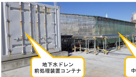
(写真3-1) 地下水ドレン中継タンクAハウスの外 観 (南東側から撮影)
