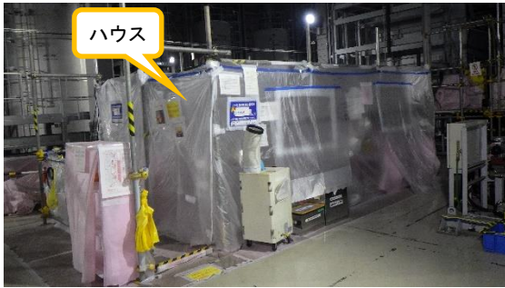
(写真1) C F F 部材解体用ハウスの設置状況
