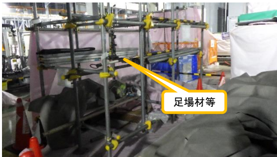
(写真2-2) 資機材の仮置き状況
