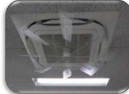
老朽空調機の更新
