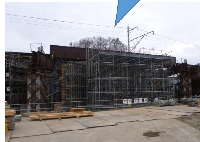
南会津町田島地内
