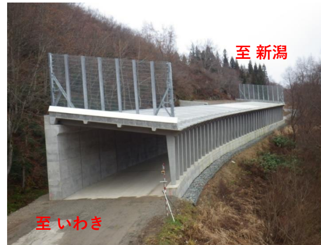
スノーシェッド 工事状況
