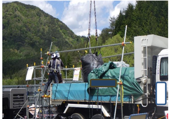
除去土壌等の積込作業
