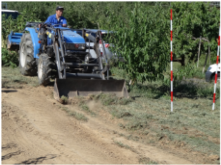
写真2 表土剥ぎ取り・集土作業 2012.09.13
