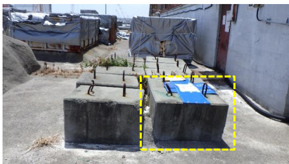
(写真3) 遮へい材が被せられたコンクリート ウェイト（北側から撮影）
