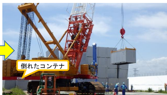
(写真 2 - 4) 同左及び作業の状況（北東側から撮 影） （6月3日撮影）
