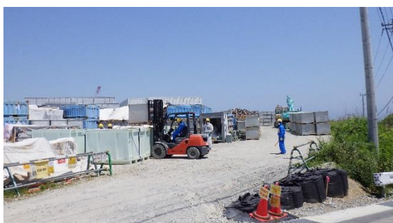
(写真4-1) コンテナ点検等作業の状況 (写真はP1エリア南側出入口付近)
