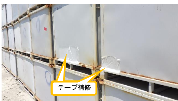
(写真4-2) コンテナの補修状況 (一時保管エリアP1南側)
