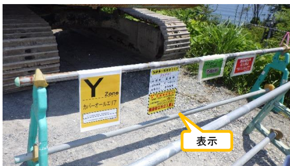
(写真2) 一時保管エリア P1 南側出入口の表示の状況 (関係者以外立入禁止、毎時 0.1 mSv 程度の瓦礫類の保管場所である旨)
