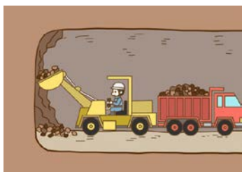
ずり出し 発破で砕けた岩 (ずり) をダンプやバールコバにてトンネル坑外へ運びます。
