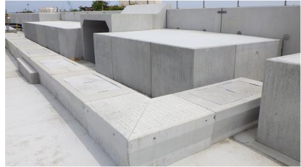
(写真 2-4) 千島海溝津波防潮堤 3～4 号機 タービン建屋側の状況 (今回撮影)
