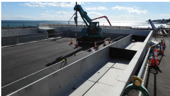
(写真2-1) 千島海溝津波防潮堤4号機タービン建屋側の状況 (前回(2月5日)撮影)
