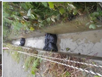
⑤エリアP南側排水溝にゼオライト土嚢を設置
