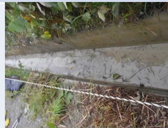
⑤エリアP南側排水溝にゼオライト土嚢を設置
