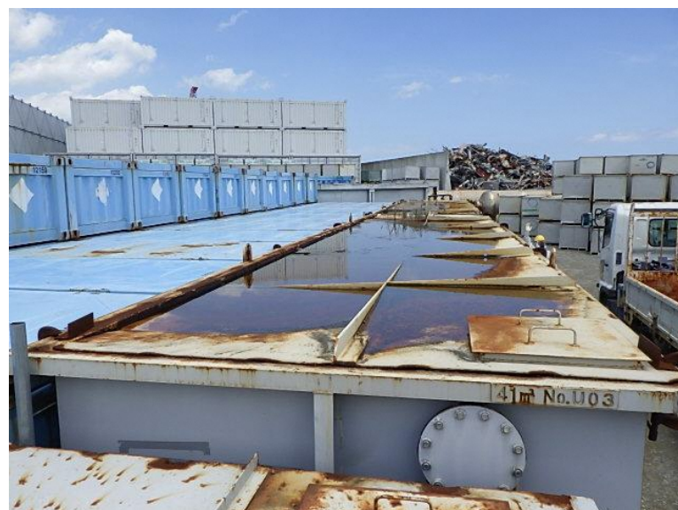
手前ハッチ蓋閉め後 (2021.7.6撮影)
