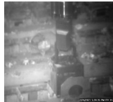
3号機での燃料の吊り上げ（566体目）
