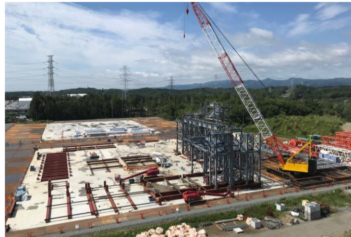
構外ヤード全景 (2021年6月21日時点)
