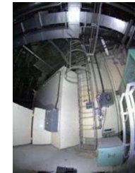
建屋内ロボット調査 (3号機1階 シェル壁 2011年9月)
