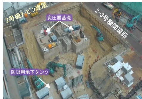
2号機原子炉建屋南側ヤード状況
