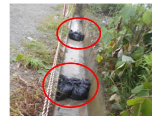
排水溝にゼオライト土嚢※1設置
