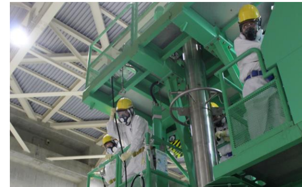
共用プールにおける作業の状況
