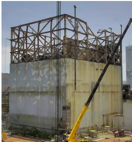
1号機原子炉建屋全景 (2021年6月3日時点)
