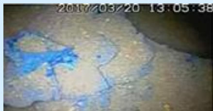
ペDESTAL※ 3 外側の状況
