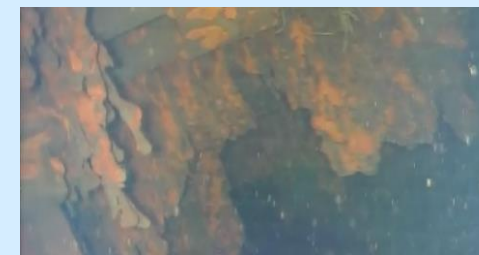
ペDESTAL※ 3 内側の状況
