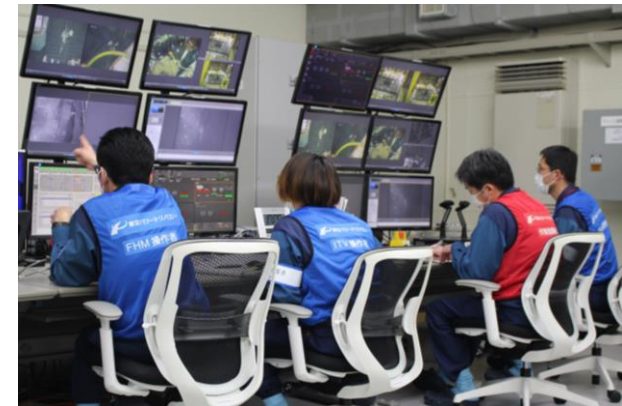
遠隔操作室における作業状況
