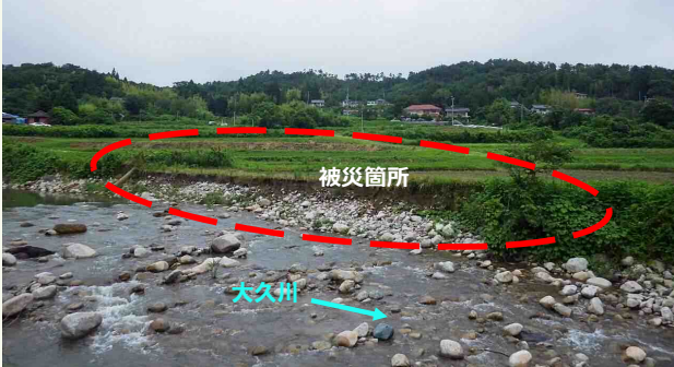
①大久町字大久字陣場地内 【施工前】
