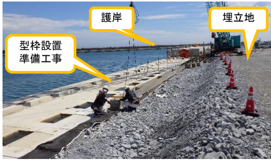
(写真3) メガフロート北側の港湾の埋立状況 及び型枠設置準備工事の状況
