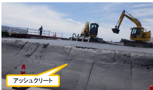
(写真2) メガフロート上部の盛土工事の状況
