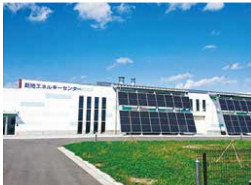
新地エネルギーセンター
