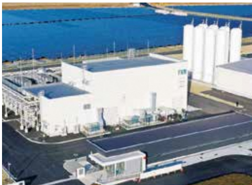
福島水素エネルギー研究フィールド
