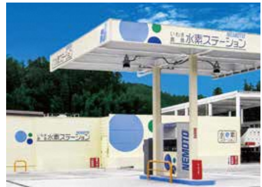
水素ステーション
