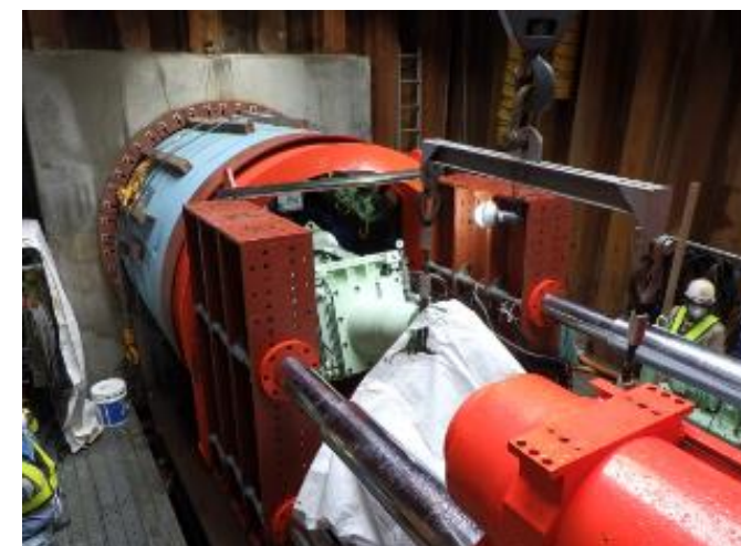
推進トンネル工法による掘削状況
