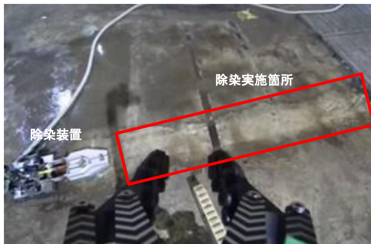
オペフロ※1線量低減 (床面の高圧水除染状況)
