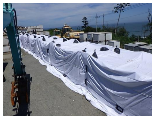
ノッチタンク仮設シート養生
