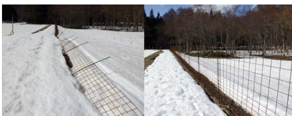
図1 融雪後の柵の状況（左：1m高柵、右：1.5m高柵） (2021年南会津町たのせ)
