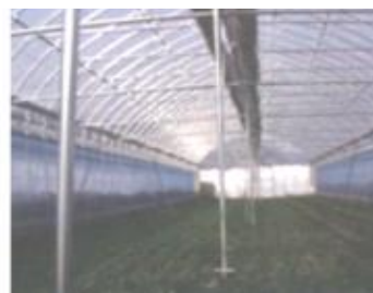
中柱（仮支柱）設置の写真
