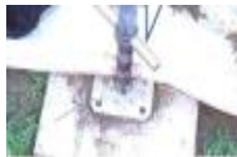
中柱（仮支柱）設置の写真
