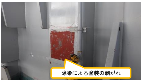
(写真2) 2号機主変圧器の試験除染の状況
