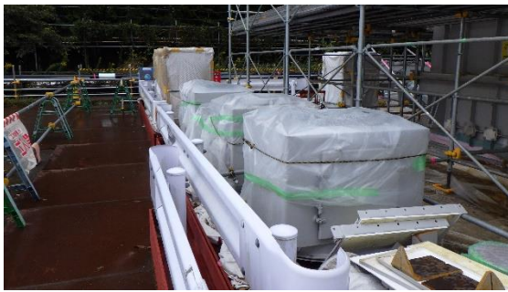
(写真3-3) 2号機所内変圧器(A)から取り外され た外装品の仮置き状況 (令和3年10 月26日撮影)
