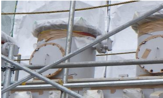
(写真3-1) 2号機所内変圧器(A)開口部の養生の 状況 (令和3年10月26日撮影)
