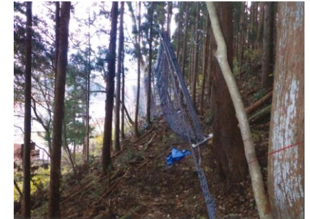
高エネルギー吸収型 落石防止柵工
