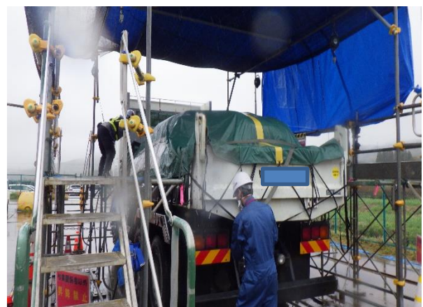
上部シートの設置
