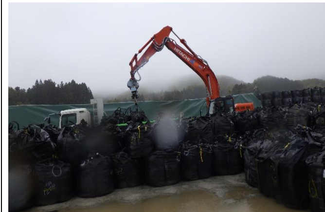
除去土壌等の積込状況
