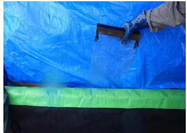
防水シートの設置(差し込み)
