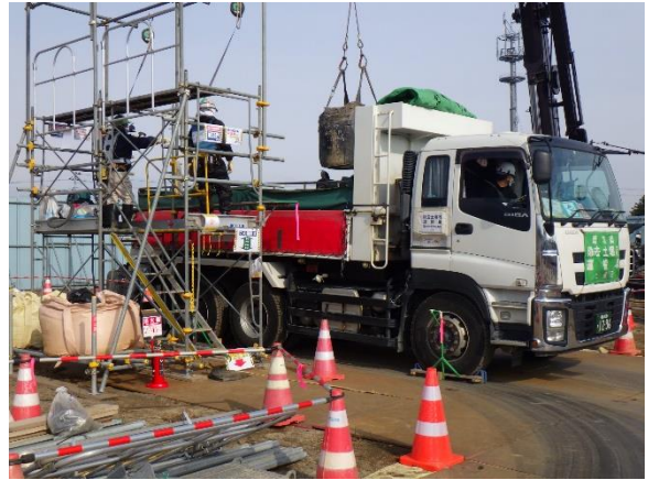
除去土壌等の積込作業
