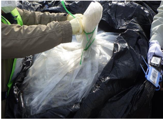
除去土壌等の封入状況
