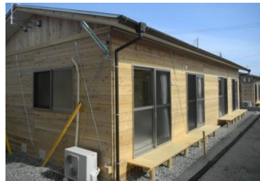
濡れ縁の設置
