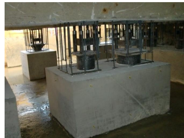
下部定着コンクリート 施工状況
