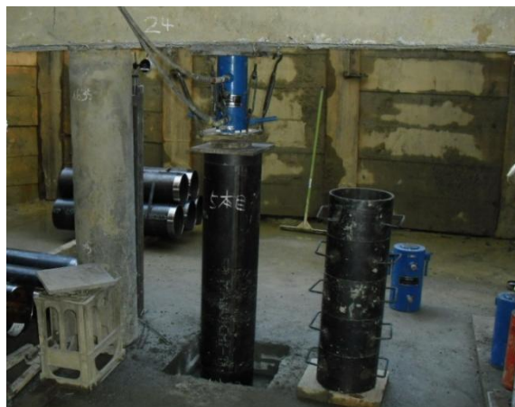
鋼管杭圧入状況
