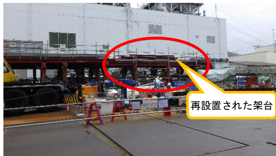
(写真 3 - 1) 鋼矢板設置用架台の再設置の状況 （東側から撮影）
