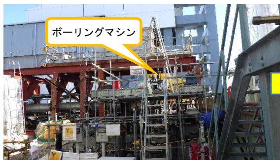
(写真1-1) ボーリング調査地点の状況① (前回(2月7日)西側から撮影)
