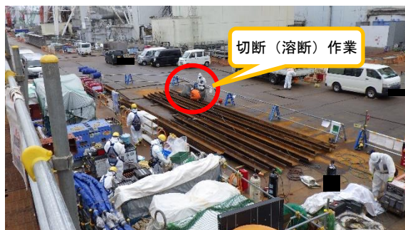
(写真 3 - 2) 鋼矢板の点検、切断作業の状況 （架台上、南東側から撮影）
