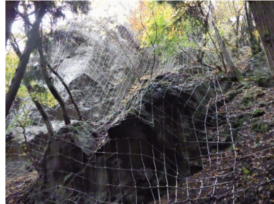
ロープネット工
