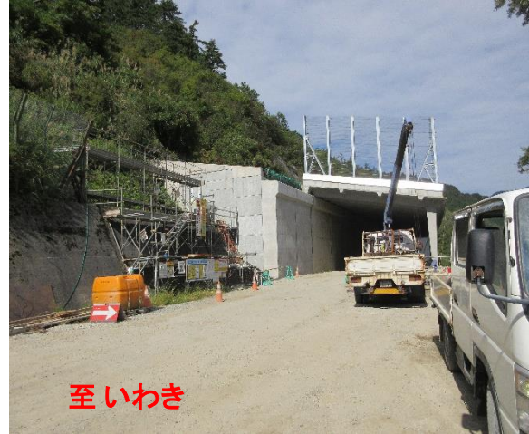
スノーシェッド工事状況
