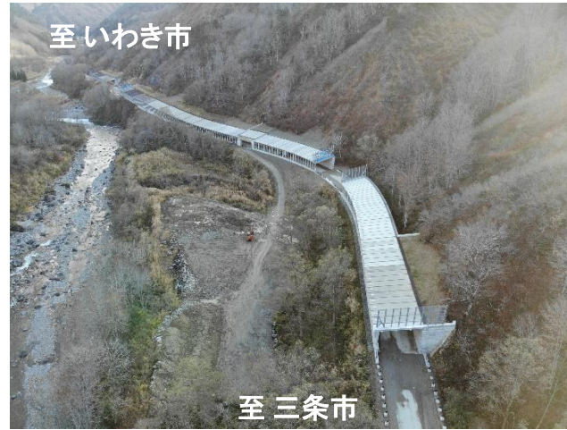
スノーシート工事状況
