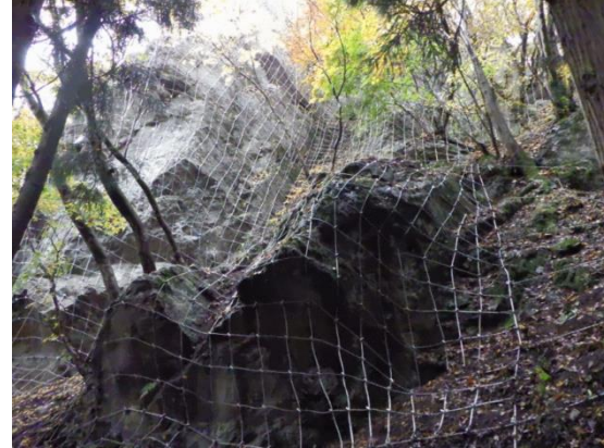
ロープネット工
