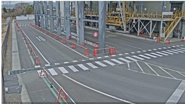
監視カメラ映像(大熊1工区)
