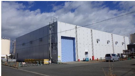
(写真 1) サブドレン他浄化設備建屋外観
