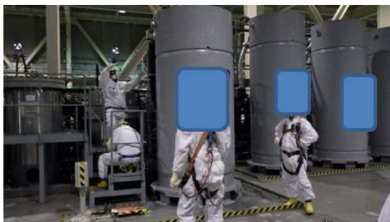
(写真 3) 作業通路の確認等の状況
