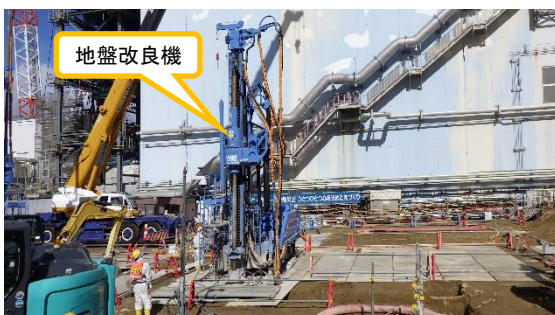
(写真4) 地盤改良工事の施工状況 (南側から撮影)
