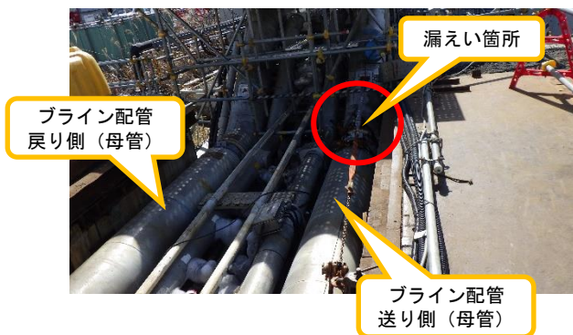
(写真2) 2・3号間山側道路横断部下部の陸側遮水壁設備の状況 (北側から撮影)
