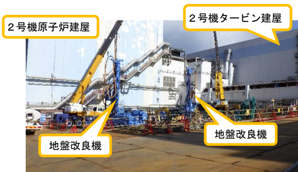
(写真3) 2号機原子炉建屋南側ヤード概観 (南西側から撮影)
