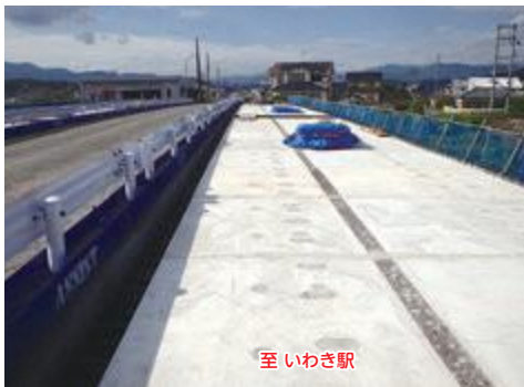
国道399号 (北目町：平川橋)
