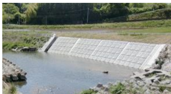
仁井田川（四倉町上柳生戸沢） 復旧完了
