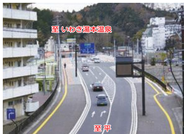
(都) 三函台山線 (湯本工区)
