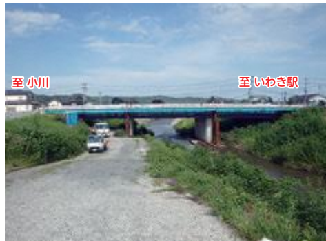
国道399号 (北目町：平川橋)
