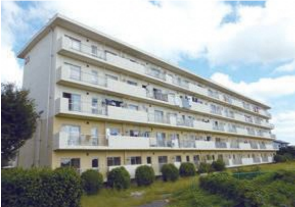
叶田団地 3号棟外壁改修工事（改修前）
