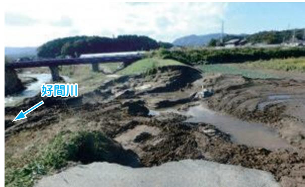
好間川 河川堤防決壊(いわき市好間町今新田)
