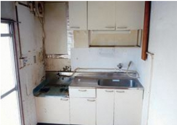
高坂団地 4号棟内部改善工事（改善前）
