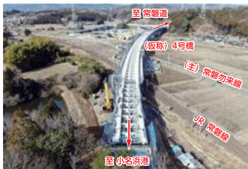
小名浜道路 ((仮称):4号橋)
