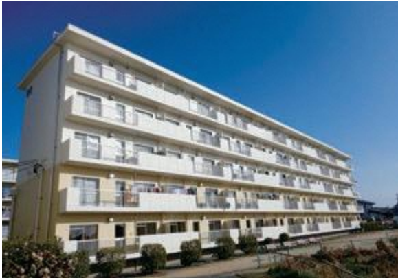
叶田団地 3号棟外壁改修工事（改修後）
