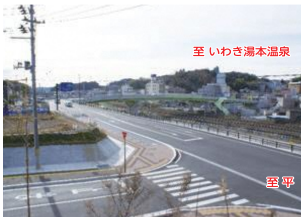
(都) 三函台山線 (湯本工区)
