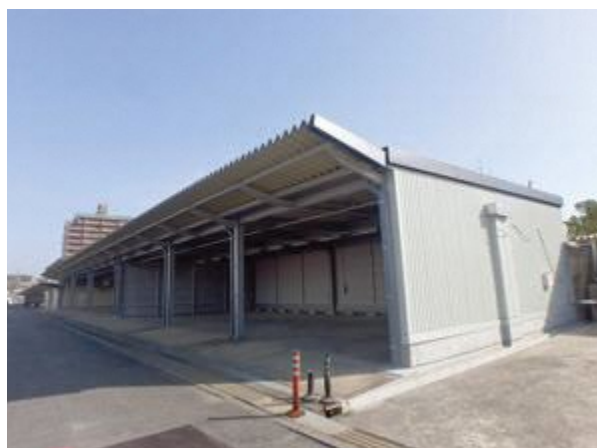
いわき合同庁舎車庫耐震改修工事
