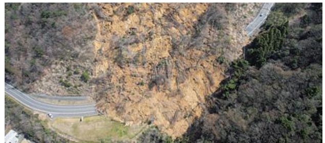
地すべり崩落〔県道いわき石川線(上釜戸地区)〕4/11地震
