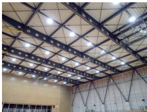
いわき光洋高校体育館照明改修工事（照明LED化）
