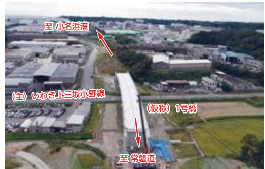
小名浜道路 ((仮称):1号橋)
