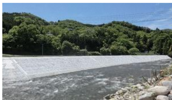
夏井川（小川町上小川） 復旧完了
