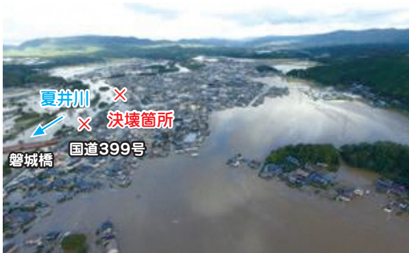
夏井川 河川堤防決壊(いわき市平下平窪)
