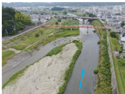
夏井川助成事業（狭窄部施工前）
