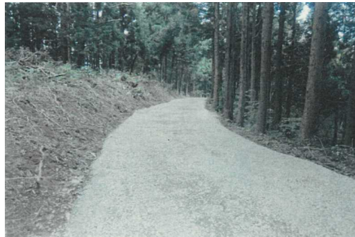
作業道の開設状況
