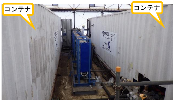
(写真 2 - 1) RO-2 建屋内の状況
