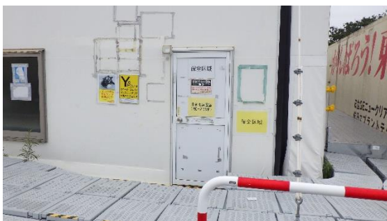
(写真1-3) RO-2MMF建屋の外観
