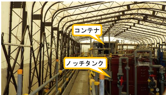
(写真4-1) RO-2MMF 建屋内の状況
