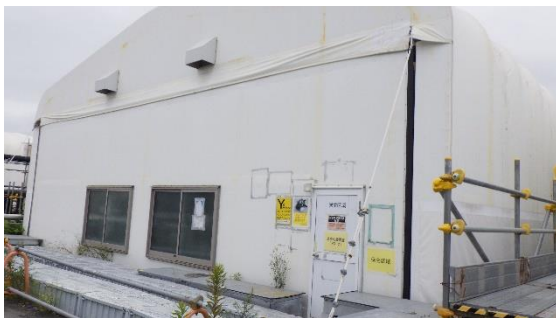
(写真1-2) RO-2建屋の外観
