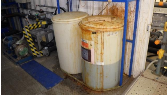
(写真4-3) コンテナ内の薬品の保管状況
