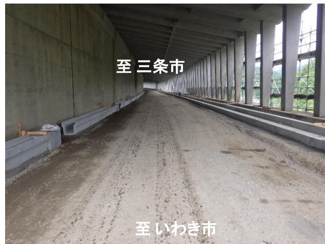
スノーシート工事状況
